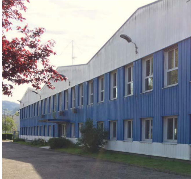
USINE SODIPAN LE NAPPAGE Saint-Etienne-du-Rouvray (76)
